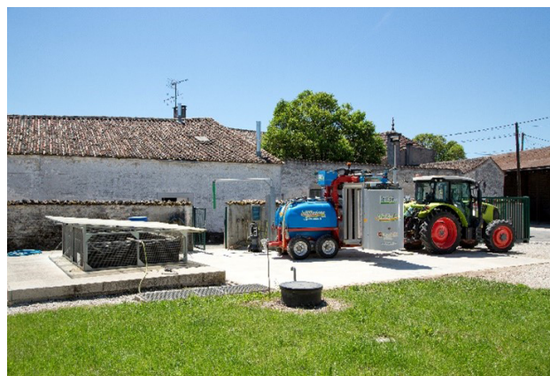
Aire de remplissage et lavage
